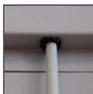
пластмассовая втулка ригельной системы
