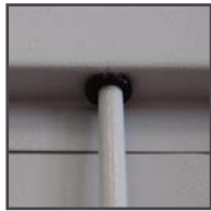
пластмассовая втулка ригельной системы
